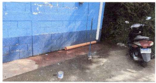
Foto 16: Reparación de bajada de agua pluvial y conducción bajo tierra de canal.
