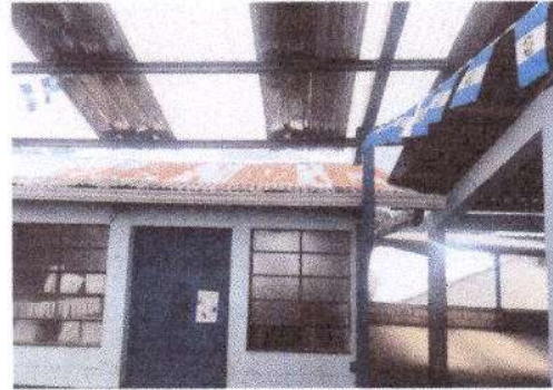
Foto 2: Aula 2: Sustitución de lamina acanalada
