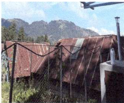
Foto 15: Reparación de muro perimetral con tubo hg y malla galvanizada en frente de los servicios sanitarios 11 metros lineales
