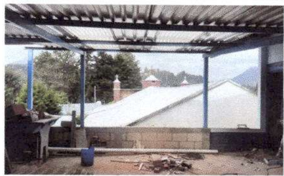
Foto 14: Reparación de muro perimetral con tubo hg y malla galvanizada al lado de cocina 7 metros lineales
