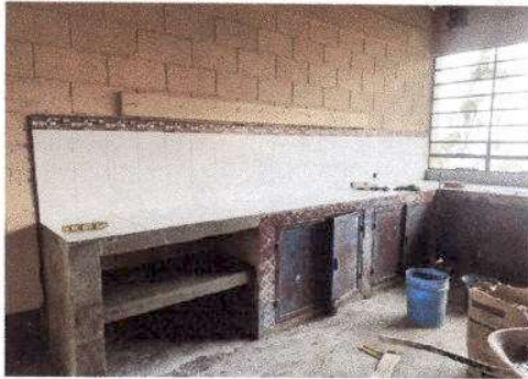
Foto 13: Colocación de 2 puertas en gabinetes de cocina
