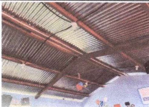
Foto 9: Auias (Sustitución de focos ahorradores)
