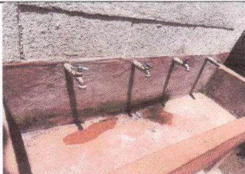
Foto 5: Servicios Sanitarios (Sustitución de grifos)
