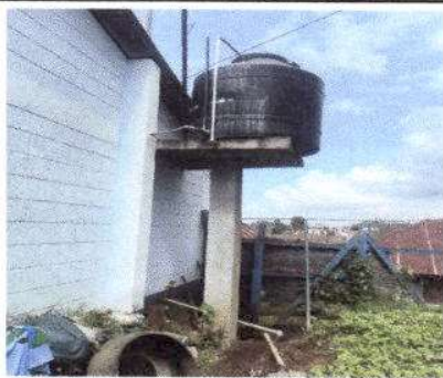
Foto 17: Reparación de cisterna de agua y construcción de tarima de concreto para sostenerla.
