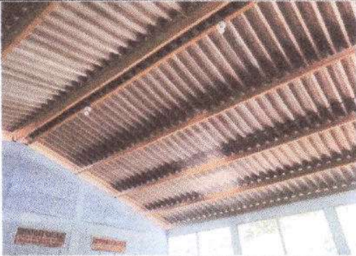
Foto 1: Aula 1: Sustitución de lámina, por lámina aluzinc calibre 26, Fabricación e instalación de ventanas de metal
